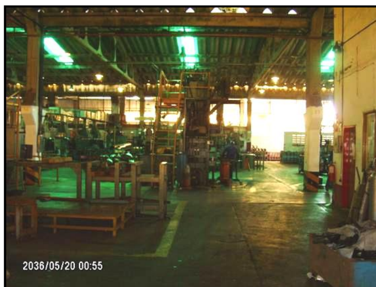
Figura 10.2.- Galpón construido con columnas de concreto armado y cerchas prefabricadas de concreto
