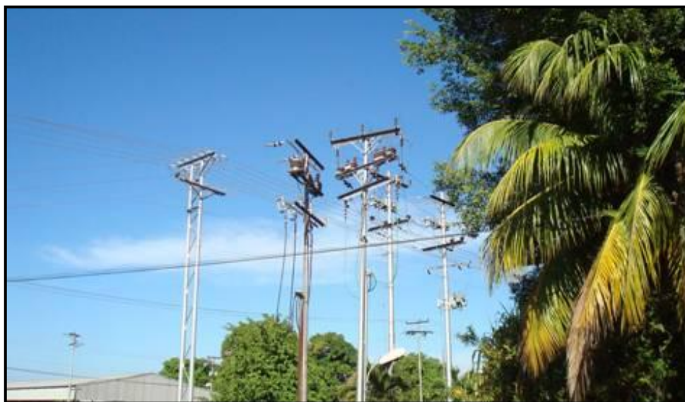
Figura 13.1.- Circuito de Alimentación en 13,8 kV
