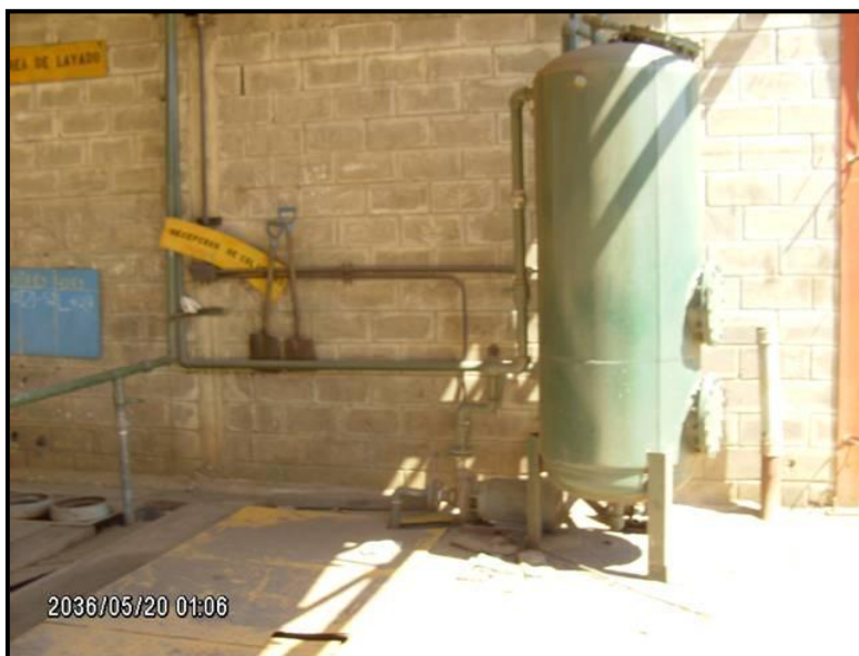
Figura 12.3.- Sistema de Agua para el lavado de cilindros
