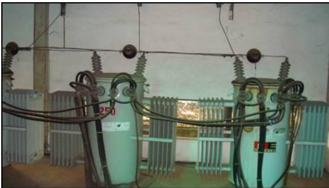
Figura 13.3.- Foto Banco de Transformadores de 250 kVA en caseta de transformadores
