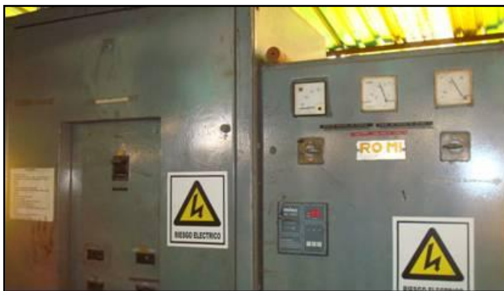
Figura 13.4.- Tablero Principal del Circuito del Banco de Transformadores de 250 kVA
