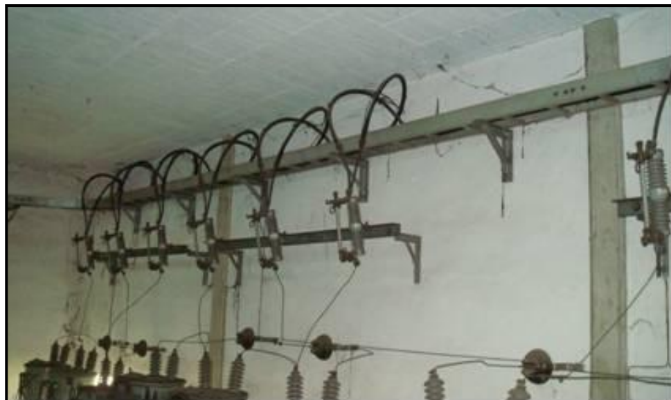
Figura 13.2.- Sistema de Protección de Transformadores en Caseta de Transformadores
